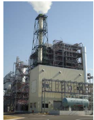
川崎バイオマス発電所
