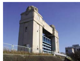
川崎河港水門
