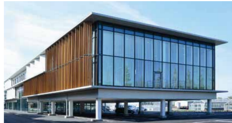
新校舎(C棟) / 外観
