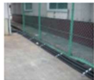
c. 地上配管 (エレックスこころがし)
