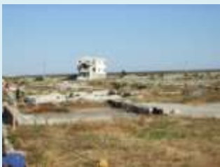
津波で流された住宅地
