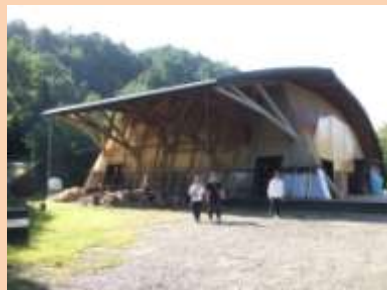
木質の梁が素晴らしい作業場
