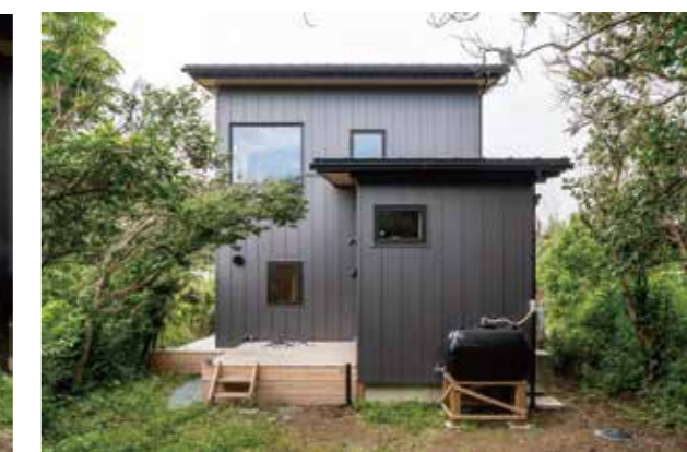
南側 500L 雨水タンク
