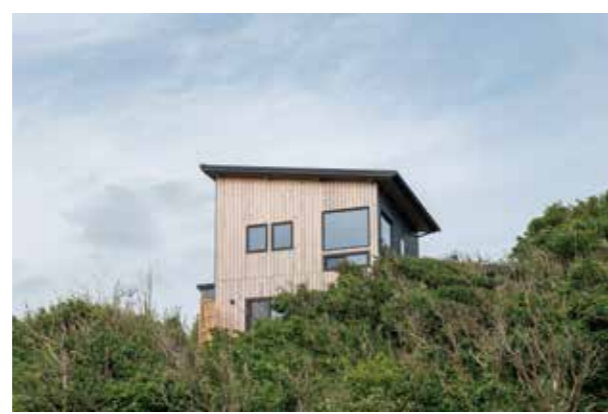
西面 海側 すのこ壁
