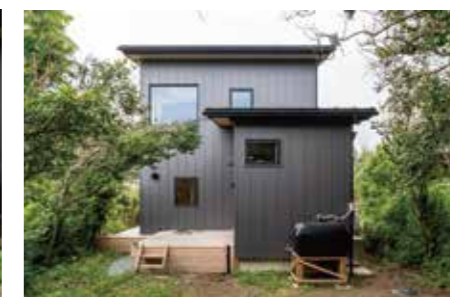
南側 500L 雨水タンク
