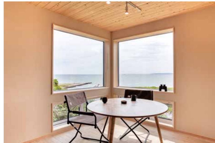
FIXの大窓の下に通風用小窓
