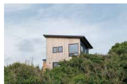
西面 海側 すのこ壁
