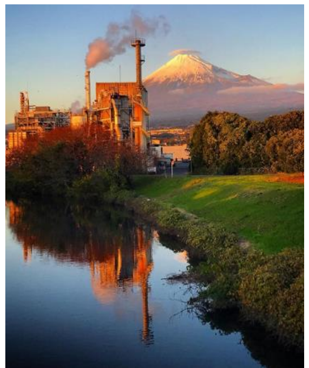
yyayyoyy (富士市新滝川橋)
