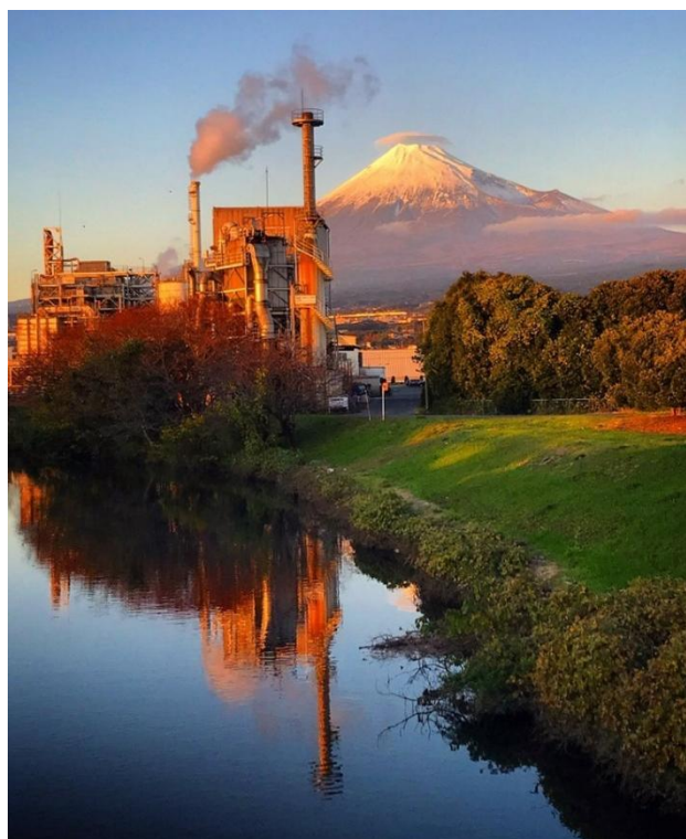
yyayyoyy (富士市新滝川橋)
