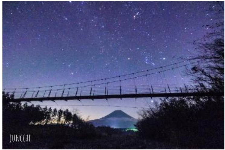
juncchi(富士宮市麓の吊り橋)
