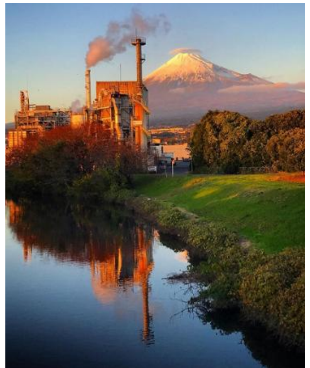
yyayyoyy (富士市新滝川橋)
