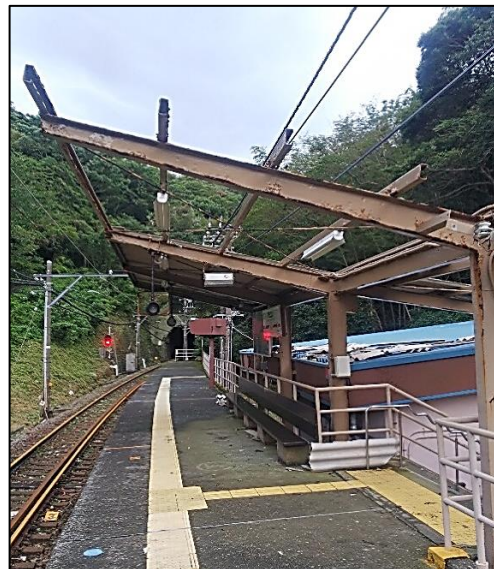
高圧配電線断線（蓮台寺駅～伊豆急下田駅間）とホーム屋根破損（伊豆北川駅）
