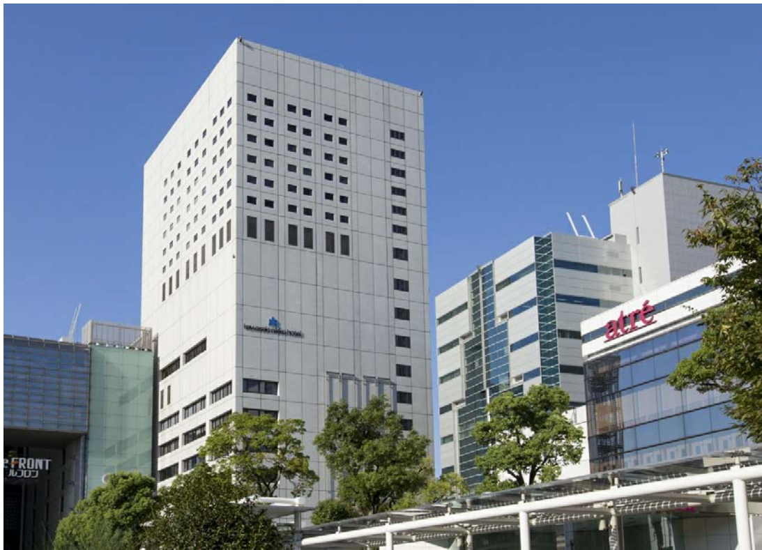
川崎日航ホテル外観
