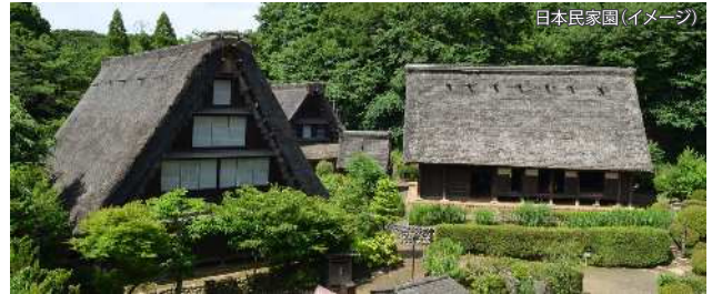
写真提供:日本民家園
