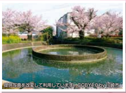
6 高津区 久地円筒分水
