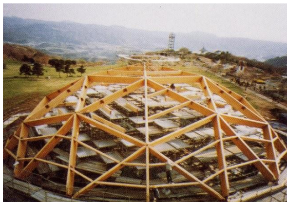
▲アグロドーム建設中の様子。建物にはニュージーランドから取り寄せたパイン材を使用しました。
