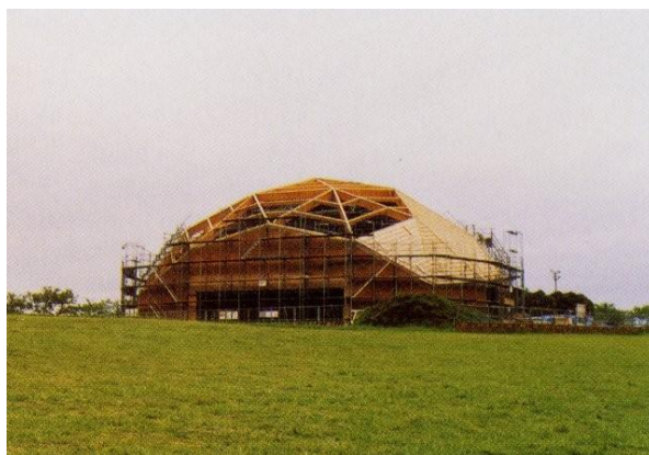
▲アグロドーム建設中の様子。建物にはニュージーランドから取り寄せたパイン材を使用しました。
