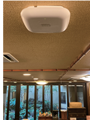
特別養護老人ホーム「ひかわ」に 設置された無線LANアクセスポ イント(D-Link製)
