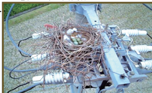
○電柱上部の開閉器の上
